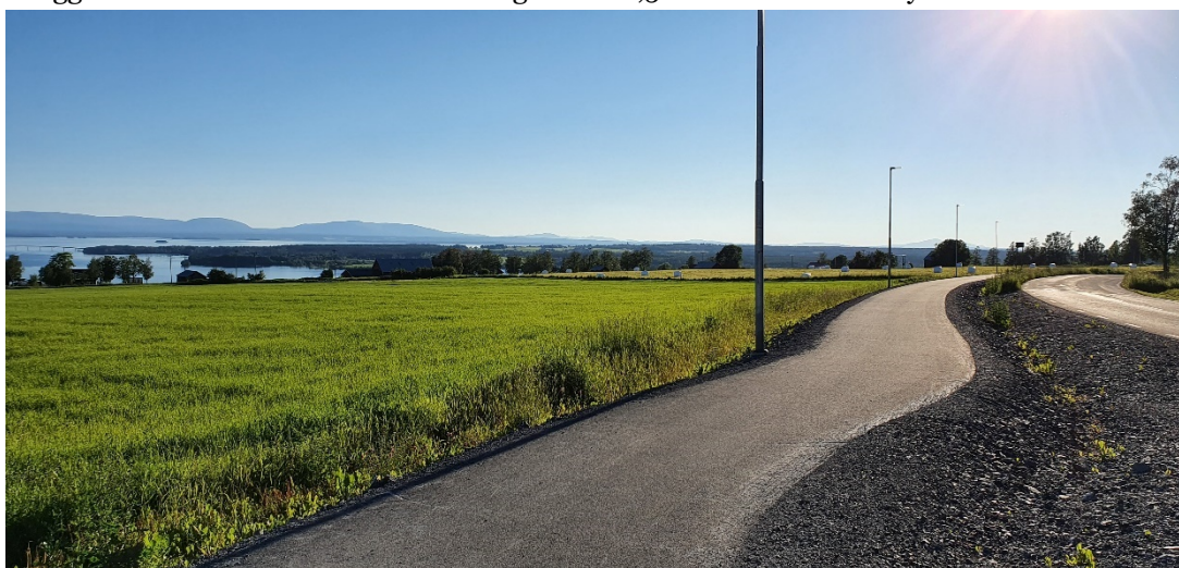
Figur 17 Gång- och cykelvägsobjekt i Ås, Krokoms kommun.
