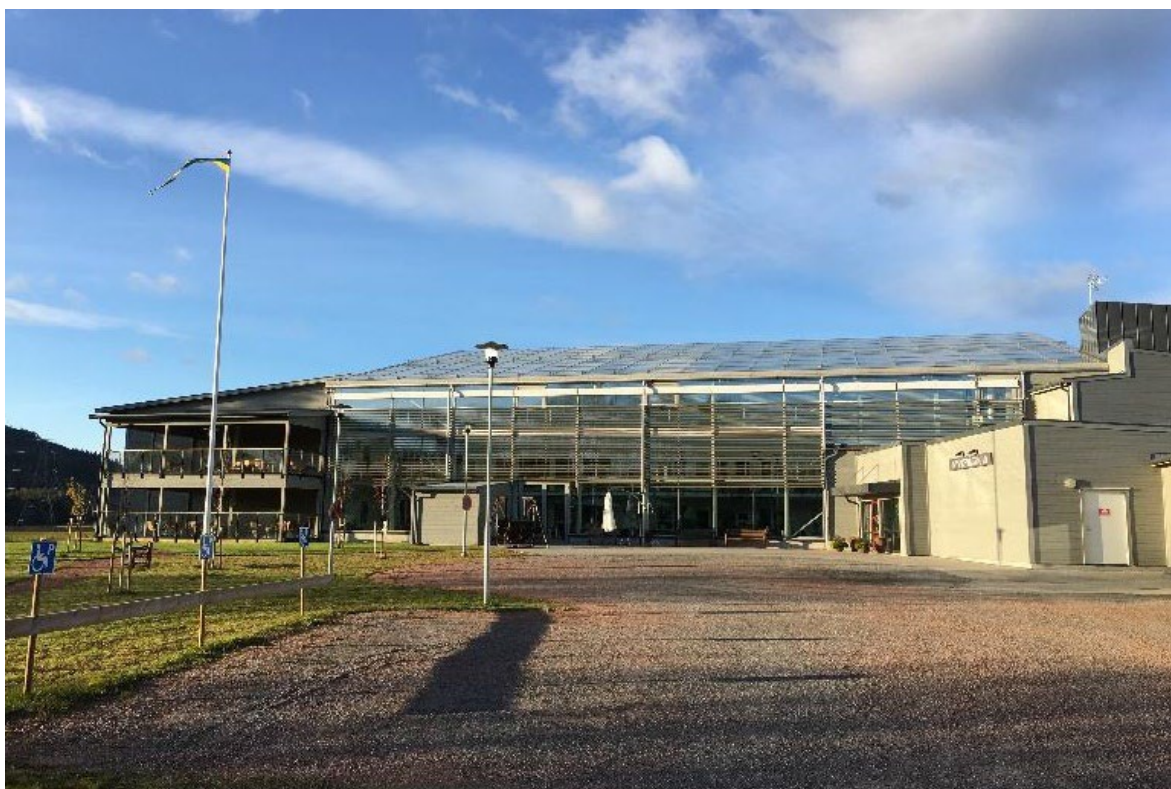
Äldreboendet Nyviksvägen i Hammarstrand.
