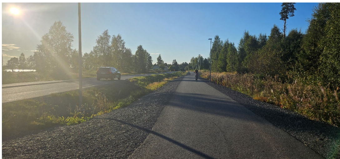
Figur 3 Gång- och cykelvägsobjekt Strömsund - Ulriksfors, Strömsunds kommun.
