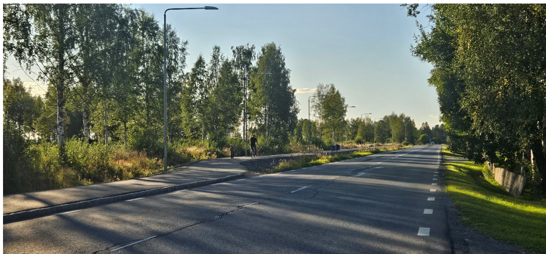
Figur 2 Gång- och cykelvägsobjekt Strömsund – Ulriksfors, Strömsunds kommun.
