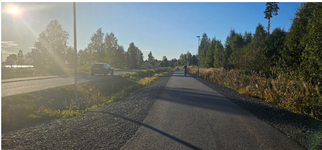
Figur 3 Gång- och cykelvägsobjekt Strömsund - Ulriksfors, Strömsunds kommun.
