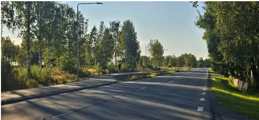
Figur 2 Gång- och cykelvägsobjekt Strömsund – Ulriksfors, Strömsunds kommun.
