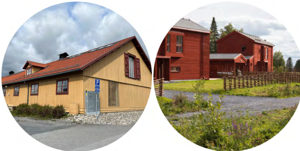
Inspirationsbilder. Bild 39. Byggnad med laduliknande gestaltning. Bild 40. Klassisk tolkning av parstuga.
