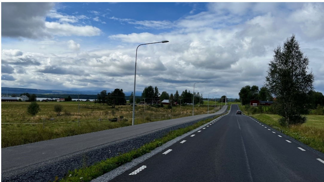
Figur 4 Gång- och cykelväg genom Hackås, Bergs kommun.
