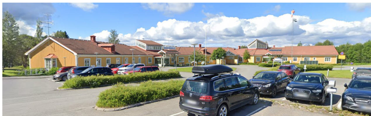
Bild 26: Entréfasad för regionens byggnad som rymmer hälsocentral och närvårdsavdelning. Foto från Google.
