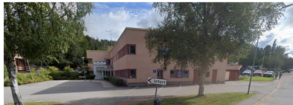
Bild 16: Regionens fastighet ligger i ett bostadsområde i centrala Bräcke ett kvarter från kommunhus, bibliotek och Folkets Hus. Byggnaden är i två våningar delvis i souterräng och byggdes på 70-talet. Foto från Google.
