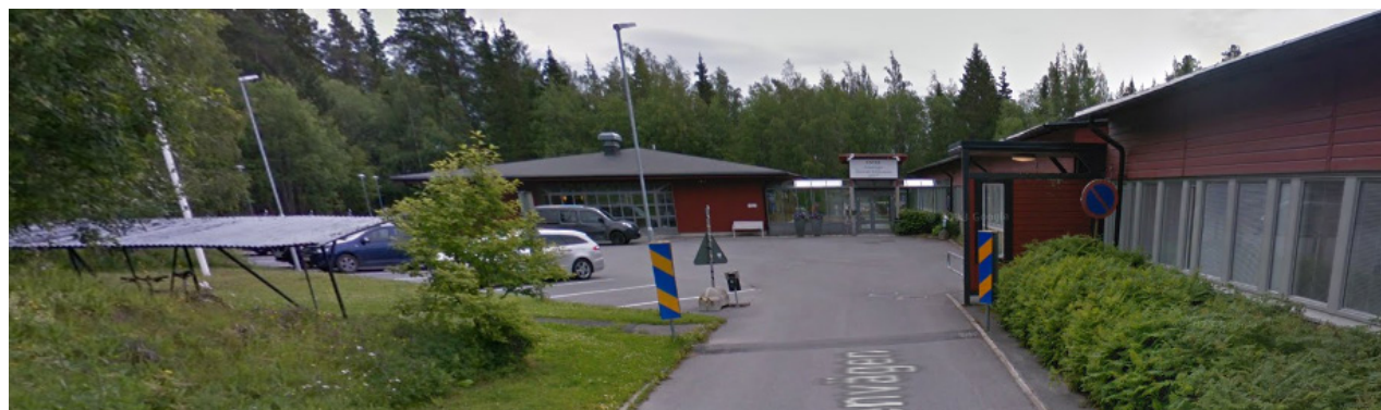
Bild 29: Entréfasad för Remonthagen. Foto från Google.
